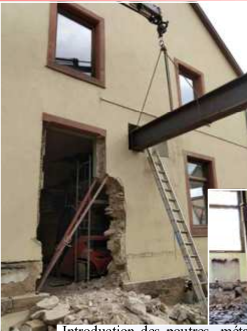
Introduction des poutres métalliques permettant de supprimer le poteau central de la grande salle de réunion.
