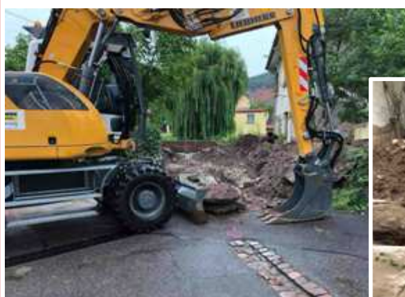
Travaux de terrassement
