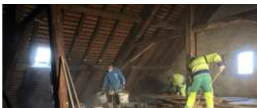
Introduction des poutres métalliques permettant de supprimer le poteau central de la grande salle de réunion.
